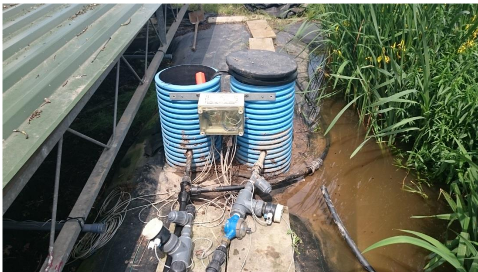
Abbildung 42: Durch die Starkniederschläge konnte Wasser aus dem Pflanzenbereich bei einer Einstauhöhe von rd. 26 cm wieder zurück ins Biobed strömen.
