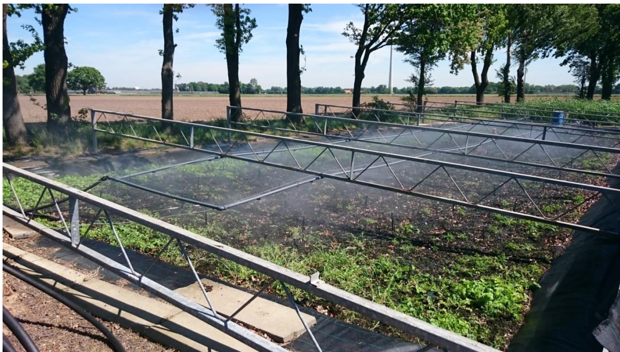
Abbildung 43: Das Biobed wurde mit zusätzlichen Düsensträngen auf dem Boden und einer Düsenrohrbewässerung, befestigt an der Dachkonstruktion ausgestattet
