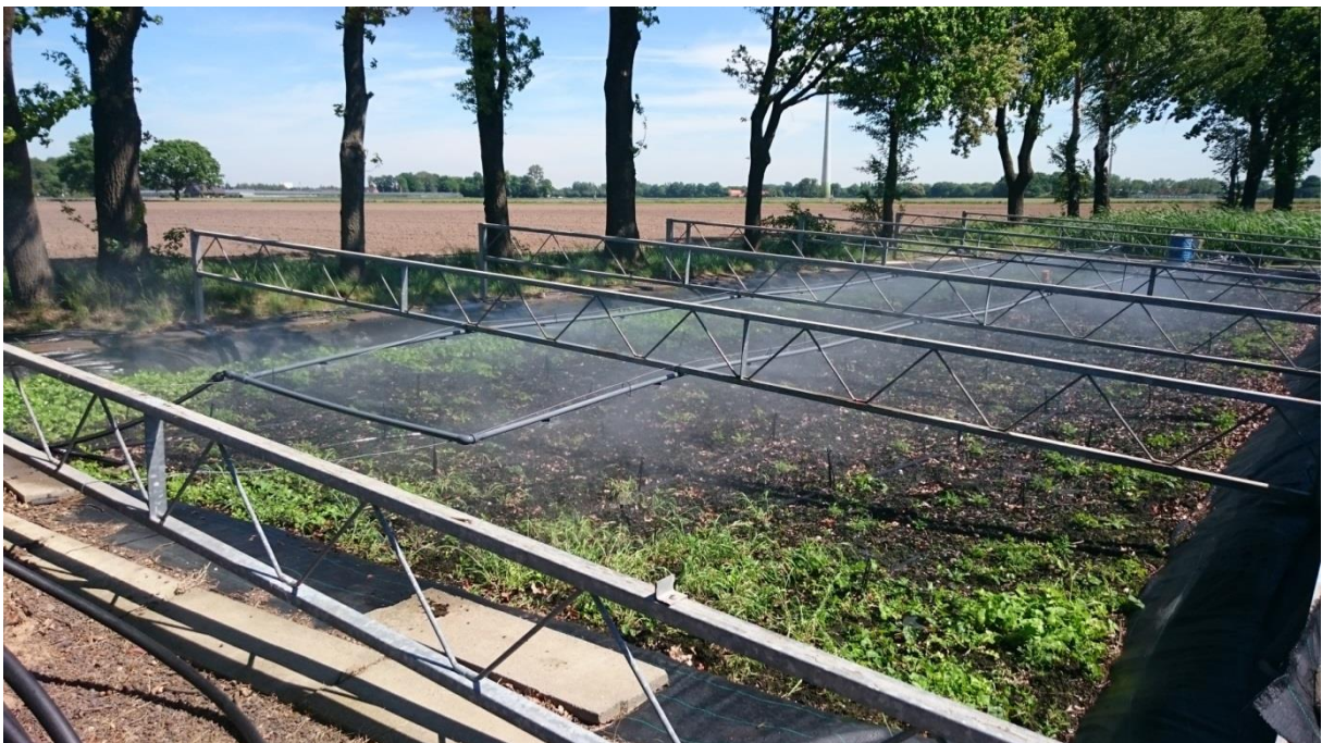
Abbildung 3: Installation eines 2. Bewässerungssystems für die Leistungsversuche Biobed (zur Beaufschlagung von Dränwassermengen von bis zu 250 m 3 /d)
