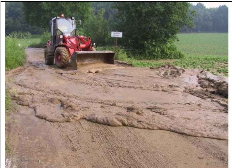
Abb. 10: Räumung einer Kreisstraße von Erosionsmaterial zur Wiederherstellung der Verkehrssicherheit
