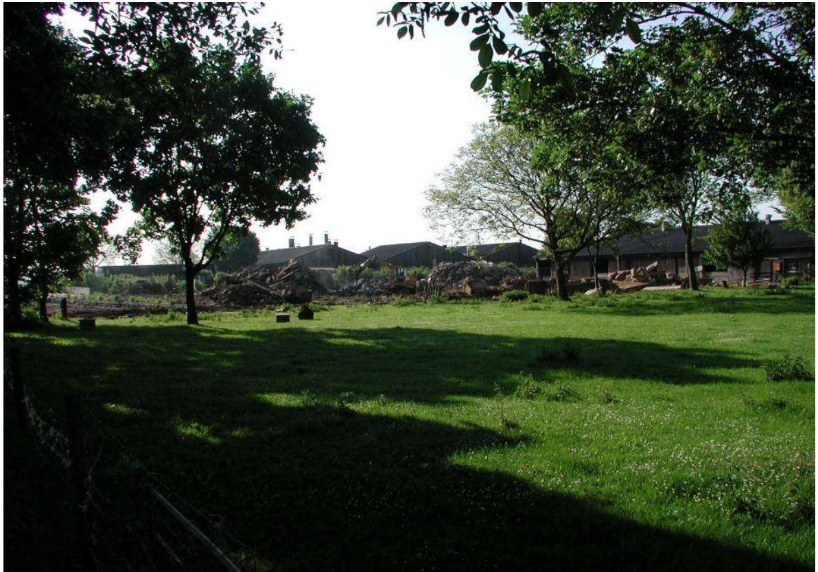
Zur Errichtung des Stalles sind die alten Gebäude Mutterkuhstall und Schafstall abgerissen worden.
