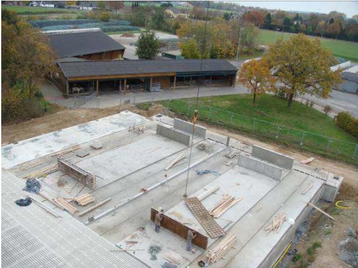
Bild: Blick auf die Baugrube am 27.10.2009
